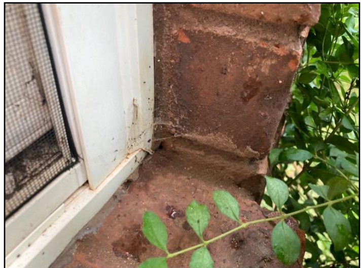
20. Caulking/mortar gap
